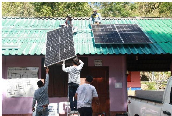
ภาพติดตั้งระบบผลิตกระแสไฟฟ้าพลังงานแสงอาทิตย์และกักเก็บพลังงานสำหรับการศึกษากองกลาง
