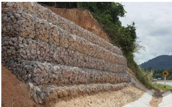
รูปที่ 4.5 การวางกล่องกะชุนหินเพื่อแก้ปัญหาเสถียรภาพของลาดดิน
