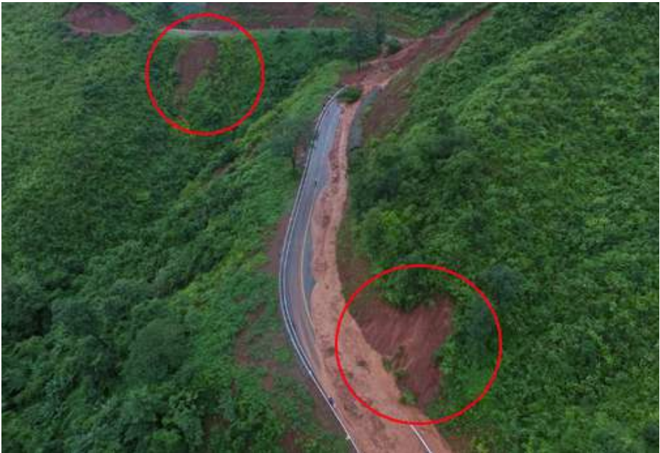
รูปที่ 2.25 ร่องรอยดินถล่มบนทางหลวง ทล.1081-0102 หลักสาย-บ่อเกลือ เมื่อวันที่ 27 เดือนกรกฎาคม 2561(ที่มา: www.thairath.co.th และ www.brighttv.co.th )
