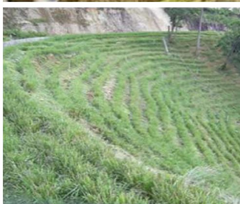
รูปที่ 4.13 การปลูกหญ้าแฝกเพิ่มเสถียรภาพของลาดดิน (ที่มา : โครงการพัฒนาและรณรงค์การใช้หญ้าแฝกอันเนื่องมาจากพระราชดำริ กรมทางหลวง 2561)
