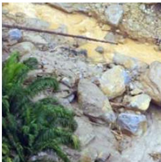
รูปที่ 2.9 ร่องรอยการเกิดดินถล่มที่ ตำบลเขาพนม อำเภอเขาพนม จังหวัดกระบี่ เมื่อวันที่ 29 มีนาคม 2554 (ที่มา: กรมทรัพยากรธรณี 2554 และ www.oknation.nationtv.tv )
