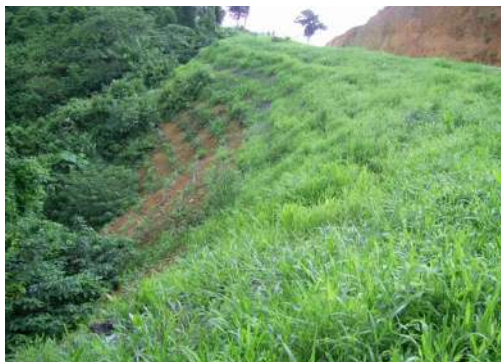
รูปที่ผ้าห่มดินและหมอนรองดิน ซ้ายมือ: หลังติดตั้ง ขวามือ: หลังผ่านไปประมาณหนึ่งเดือน (ที่มา: facebook ผ้าห่มดิน หมอนกันดิน : Erosion Control)
