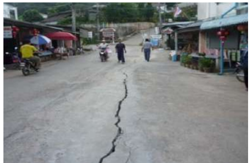
รูปที่ 1.29 ภาพรอยร้าวเริ่มต้น และสภาพพื้นที่ก่อน และระหว่างเกิดรอยแยกใหม่ๆ ที่หมู่บ้านสันศิริ ดอยแม่สลอง (ที่มา: กรมทรัพยากรธรณี (2558) เว็บไซต์หนังสือพิมพ์ผู้จัดการ เว็บไซต์เชียงรายโพสต์)
