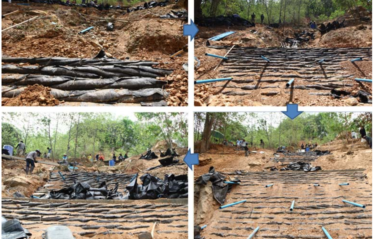
ภาพที่ 4.38 การเรียงกระสอบมีปีกจากด้านล่างขึ้นสู่ด้านบน
