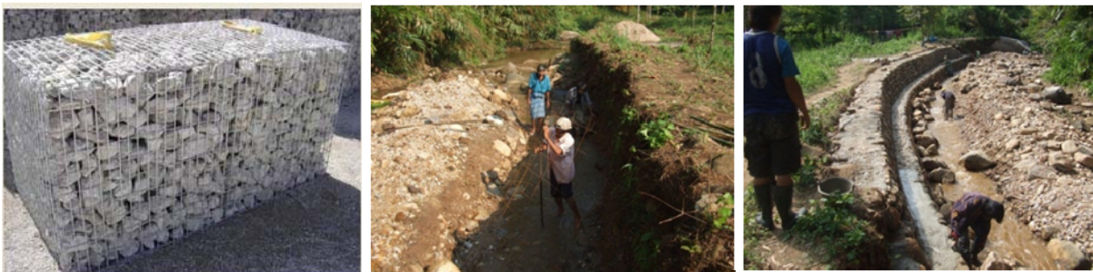
ภาพที่ 4.29 ภาพตัวอย่างกล่องหินและการเรียงกล่องหิน (Gabion) ในพื้นที่โครงการก่อสร้างก้าซฯ ไทย-เมียนมา จังหวัดกาญจนบุรี
