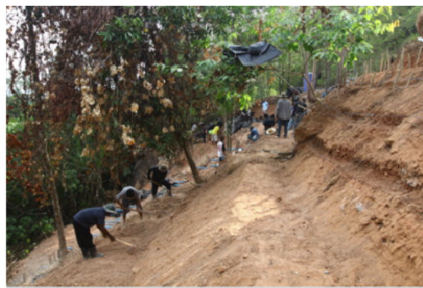
ภาพที่ 4.25 การขุดตัดทำชั้นบันได
