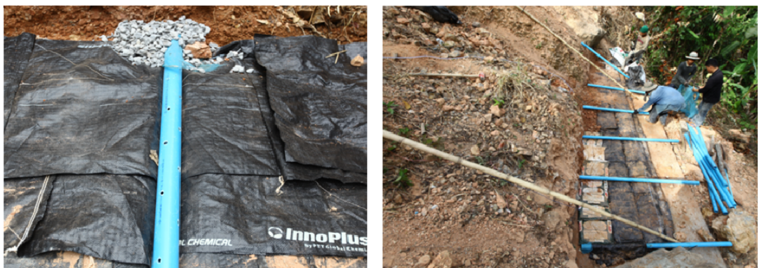
ภาพที่ 4.34 การวางท่อพีวีซีเพื่อระบายน้ำใต้ดิน
