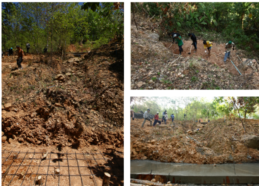
ภาพที่ 4.31 การทำฐานชั้นที่ 1 สำหรับเรียงกระสอบมีปีก
