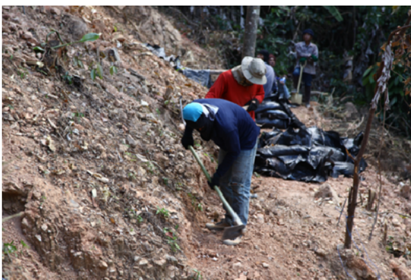
ภาพที่ 4.25 การขุดตัดทำชั้นบันได
