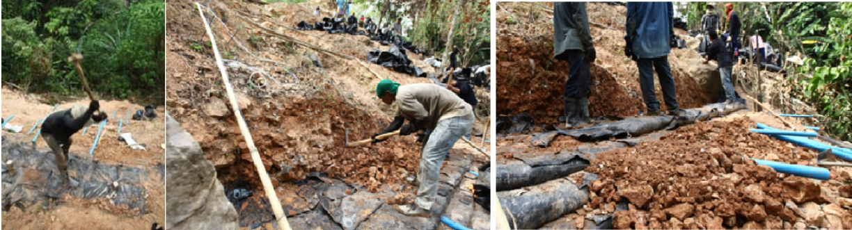
ภาพที่ 4.35 การตอกไม้เสาค้ำและนำดินกลบกระสอบมีปีก
